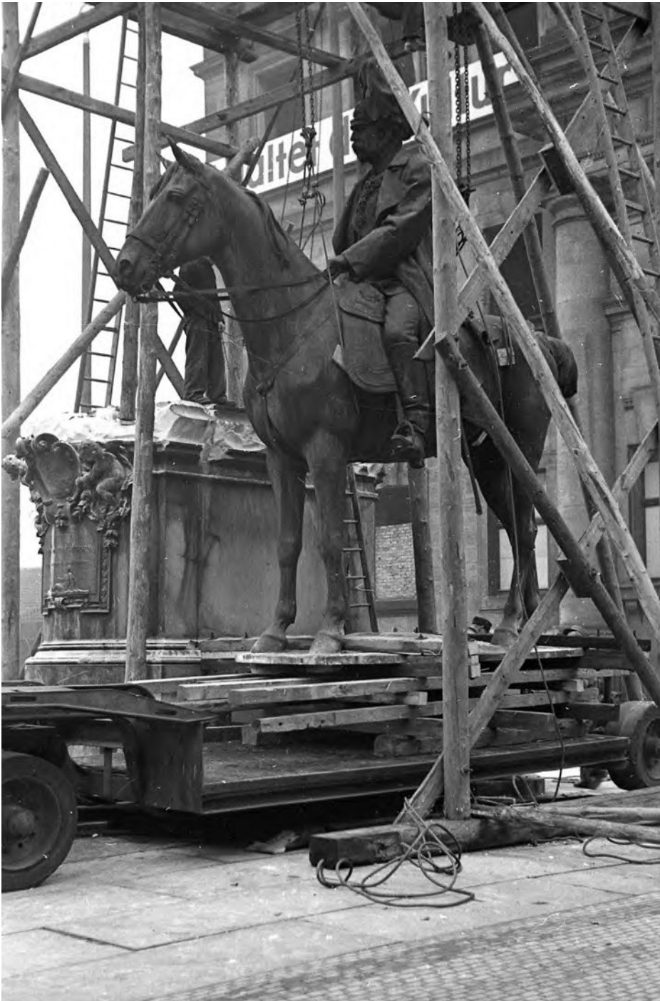
Abb. 1: Abbau des König-Albert-Denkmal am 4. November 1950.
