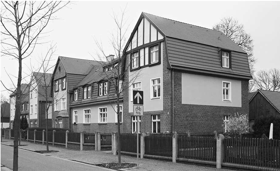
Abb. 10: Kolonie Marga, Zehnfamilienhaus Typus A (A1 – Ernst-Thälmann-Straße), Split-Level: Gut erkennbar ist der Niveauunterschied der Fenster im Mittelteil gegenüber den Seitenbereichen der Fassade.
